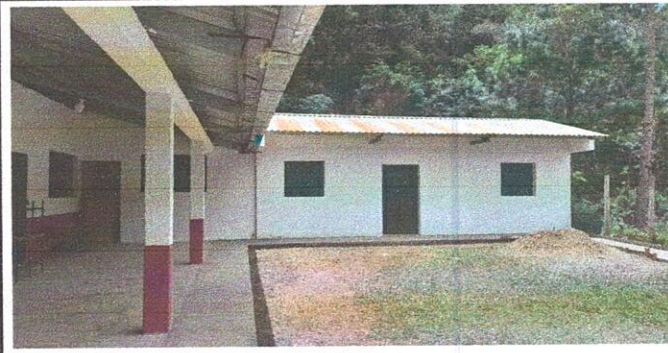
Foto 4: Se observa aplicación de pintura exterir en módulo dos, instalcion electrica, fundición de banquetas, aplicación de repello y cernido exterior en cocina, unificación de modulos.
